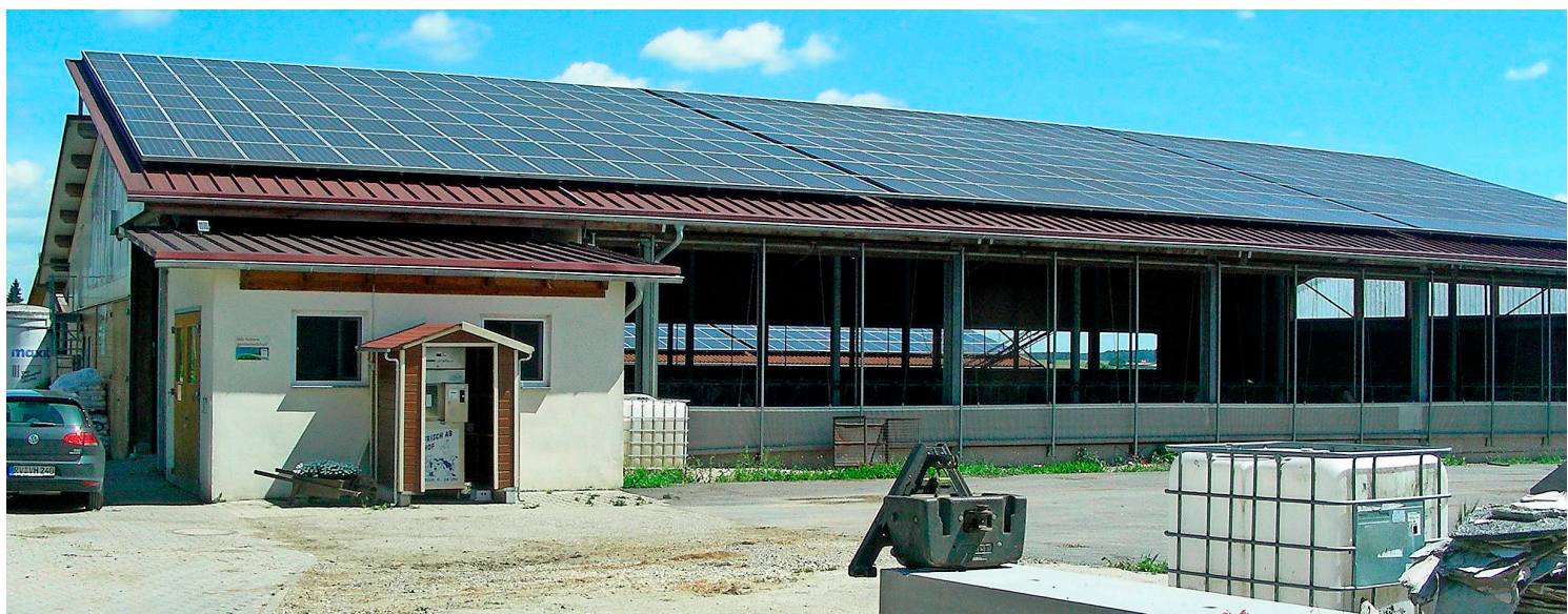
Bereits seit 2011 hat Familie Traber eine Photovoltaikanlage mit 142 kWp in Betrieb. Geplant wurde im Zuge der Beratung, die Eigenstromnutzung noch weiter zu steigern.
