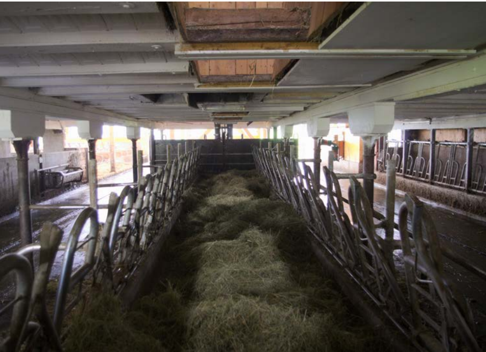
Bild 2: Innenumbau in einem Schwarzwaldhof mit schmalem Futtertisch, der von oben befüllt wird (Foto: LRA Emmendingen)
