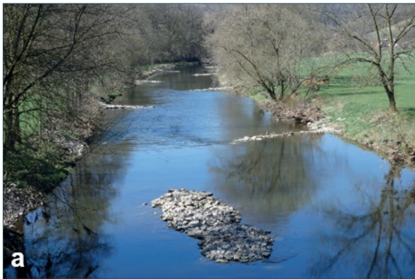
Abb. 37: Kiesinsel und Bühnen bei Kleinforst (Umsetzung: Oktober 2016) nach Fertigstellung (a) und im September 2019 (b).
