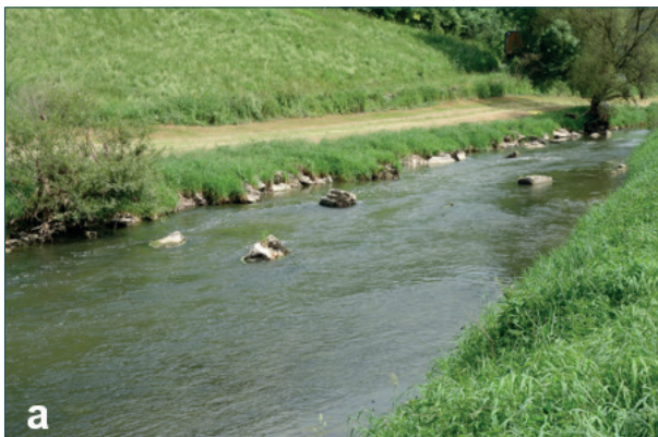
Abb. 39: Störsteine zwischen Hessenau und Elpershofen (Umsetzung: Dezember 2015) nach Fertigstellung (a) und im September 2019 (b).
