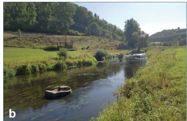
Abb. 39: Störsteine zwischen Hessenau und Elpershofen (Umsetzung: Dezember 2015) nach Fertigstellung (a) und im September 2019 (b).
